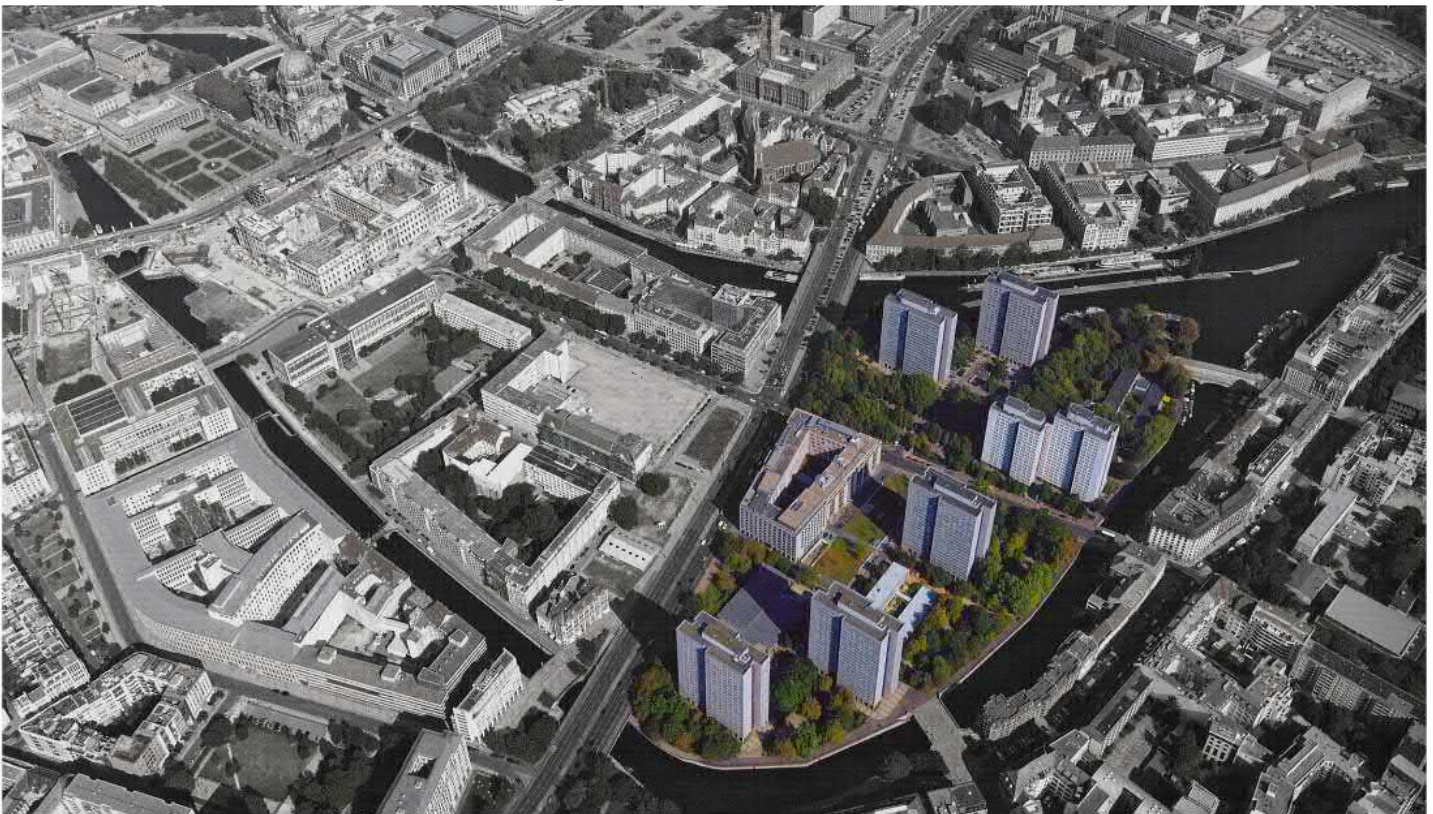
Abb. 2: Luftbild südliche Spreeinsel 2008, P.Meuser
