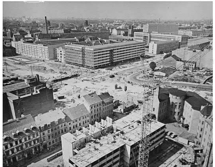
Abb. 21: Baustelle an der Gertraudenstraße, um 1969 Unbekannt
