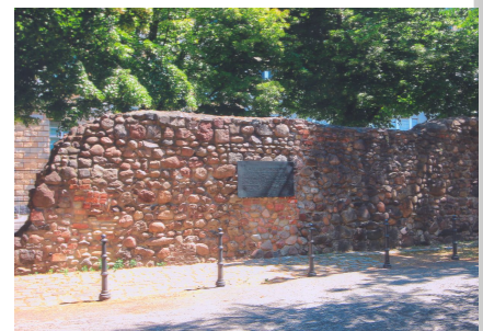
Bild 2 : Die aufgestockte Mauer
