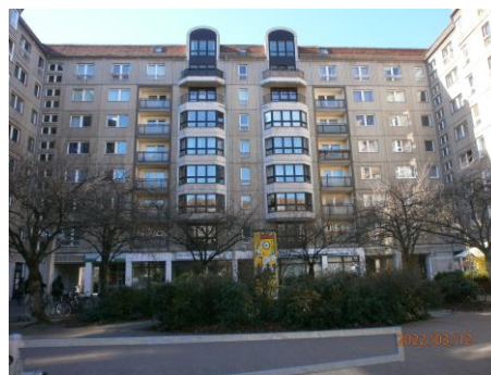
Plattenbauten mit neuartigen Haus-Segmenten in der Wilhelmstraße-West
