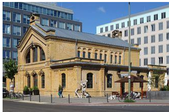
Empfangsgebäude der Vorortbahn
