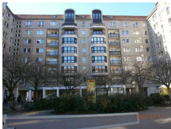
Plattenbauten mit neuartigen Haus-Segmenten in der Wilhelmstraße-West
