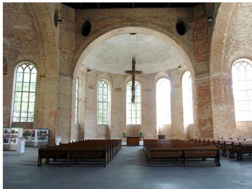
Von 1990 bis 2005 wurden erhebliche Instandsetzungs- und Sanierungsarbeiten durchgeführt. Ziel war es, die historische Substanz zu erhalten. Der Innenraum des Kirchenschiffs wurde als unverputztes Mauerwerk hergestellt, anders als der historische Zustand und auch ohne die vier Emporen über den vier Apsiden.
