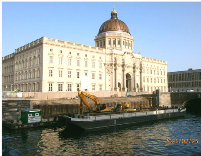
*Abbruch der Ufermauer für die Freitreppe, ein Zugang zum Baden*
