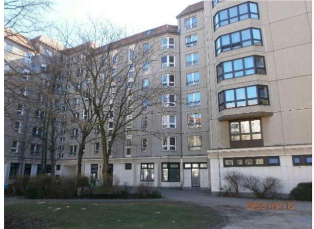
Für den Bau wurden Platten der Wohnungsbauserie 70 (WBS 70) verwendet, die an diesem Ort eine neue Flexibilität ermöglichen sollte. Mehr als die vorangegangenen Serien eröffnete die WBS 70 Spielräume für Gestaltung, Grundrisszuschnitte und die Einpassung in die Nachbarbebauung.<sup>6</sup> Mit Erkern, Balkonen, Gauben und Loggien, betonten Ecken und Mittelachsen wies die Fassadengestaltung eine Vielfalt an Variationen auf.
