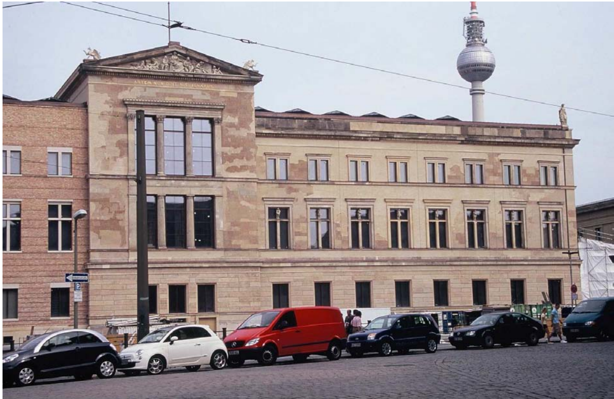
Abb. 27: Die verunstaltete Westfassade des Treppenhauses und des Südflügels
