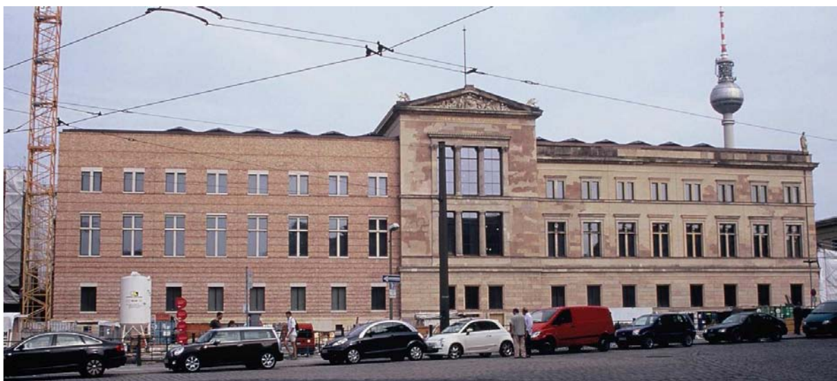
Abb. 20: Durchbrechung des Prinzips der Symmetrie beim Wiederaufbau der Nordwestfassade durch Chipperfield.
