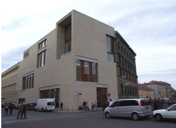
Abb. 12: Neubau von David Chipperfield an der Ecke Am Kupfergraben / Hinter dem Gießhaus, direkt gegenüber dem Neuen Museum. Blick nach Nordwesten.
