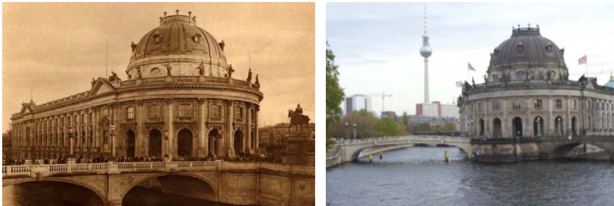
Abb. 11 a und b: Der nördliche Teil der Monbijoubücke ( im Bild links) wurde im Gegensatz zum historischen Vorbild (links) ohne Mittelpfeiler und mit einer Wölbung rekonstruiert, die beim südlichen Teil der Brücke fehlt und daher eine unschöne Asymmetrie erzeugt.
