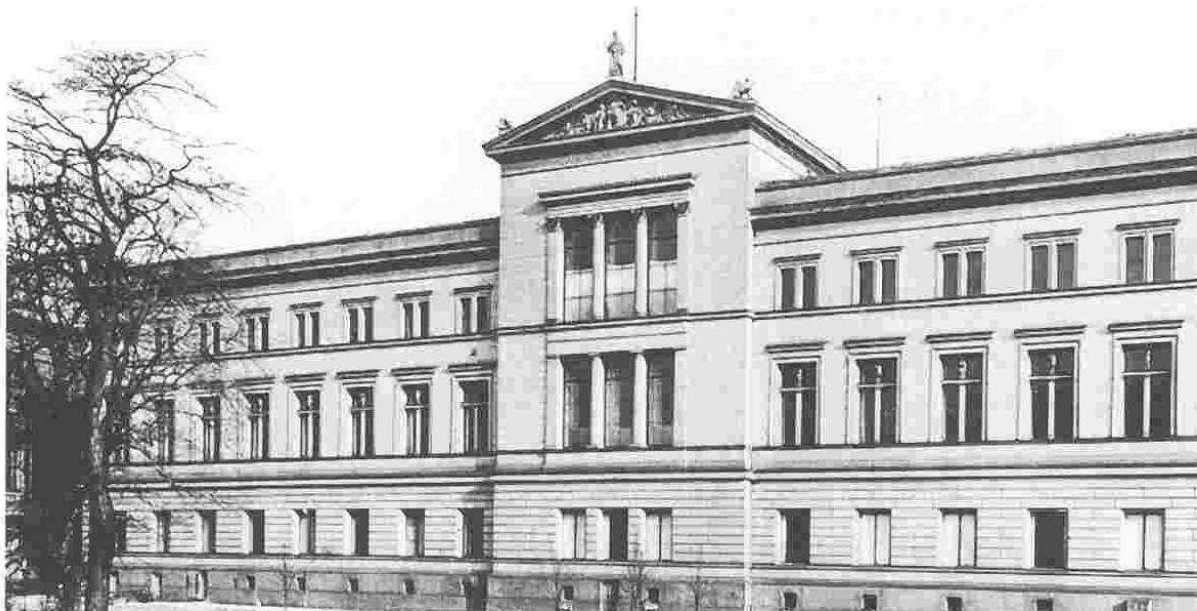
Abb. 14: Historische Ansicht des Neuen Museums
