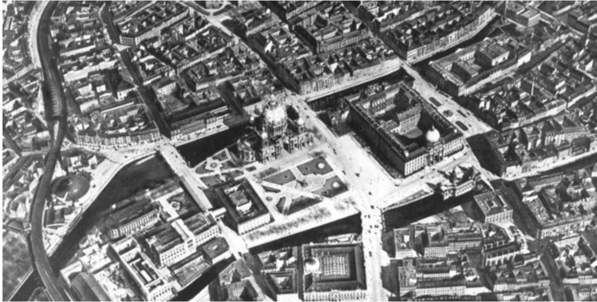
Abb. 8: Stadträumliche Korrespondenz von Schloss und Altem Museum (Luftaufnahme von 1920)
