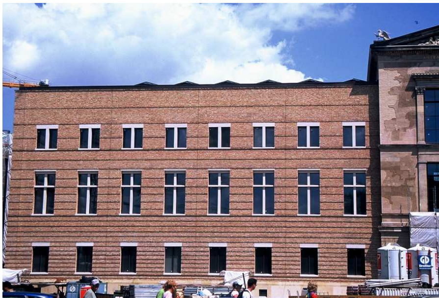
Abb. 23: Die neue Nordwestfassade im Stile eines post-modernen Industriebaus; Rohziegelmauerwerk ohne Dachgesims, mit höhlenartigen Fensteröffnungen ohne Dachung, Rahmen und Simse sowie mit hervortretenden Ziegelumgürtungen als neuem Gliederungselement.
